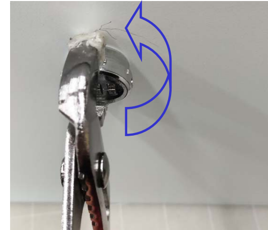
反時計周りに90度回転させる。 (回転時には抵抗がありますので力を込めて回してください)
